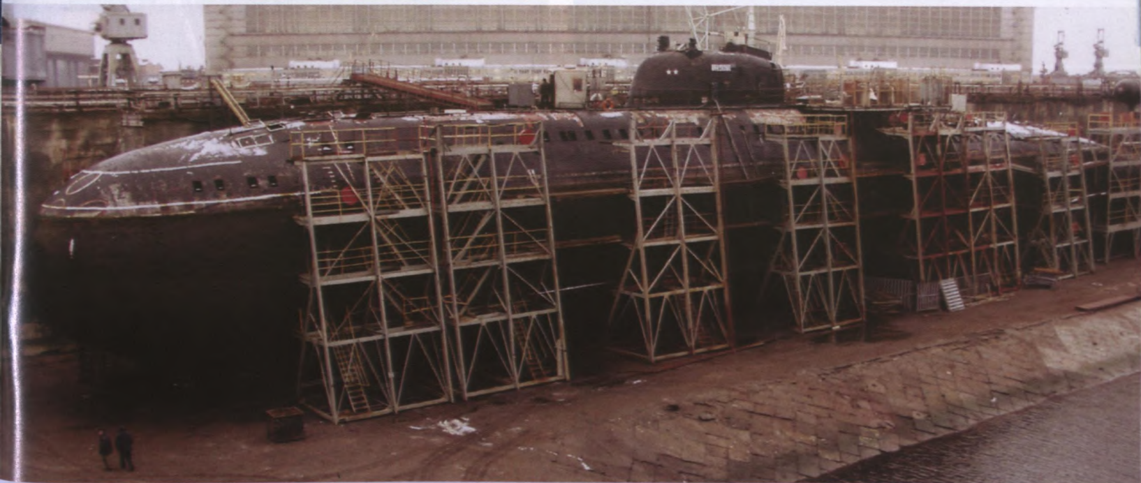
Sous-marin de la classe « Victor III » en cale sèche en cours de démantèlement
