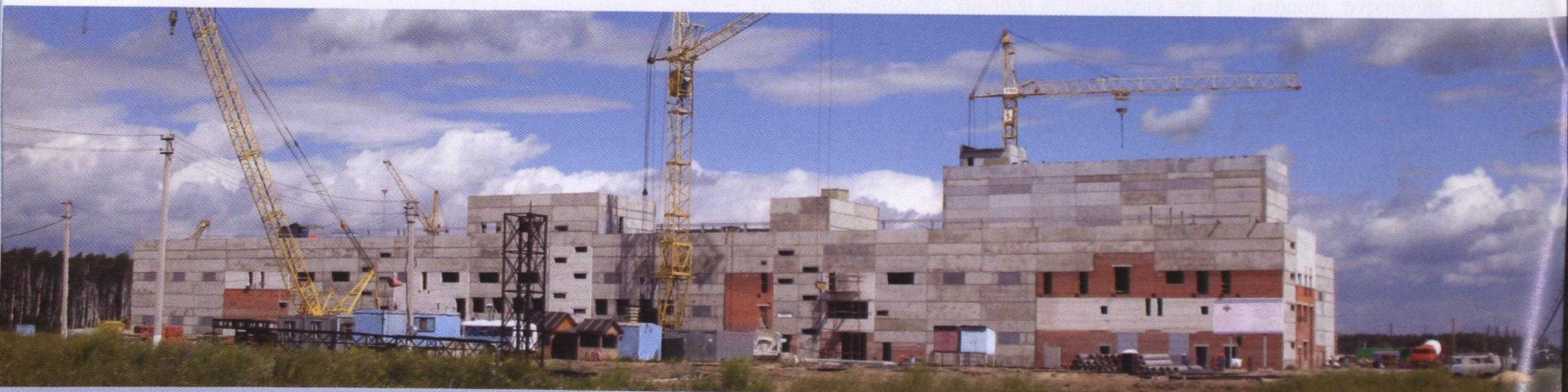
Deuxième bâtiment de destruction, à l'usine de destruction d'armes chimiques de Shchuch'ye
