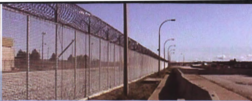
L'érection de clôtures autour du périmètre de sécurité empêche les terroristes d'accéder aux matières nucléaires dangereuses. Photo : Commission canadienne de sûreté nucléaire
