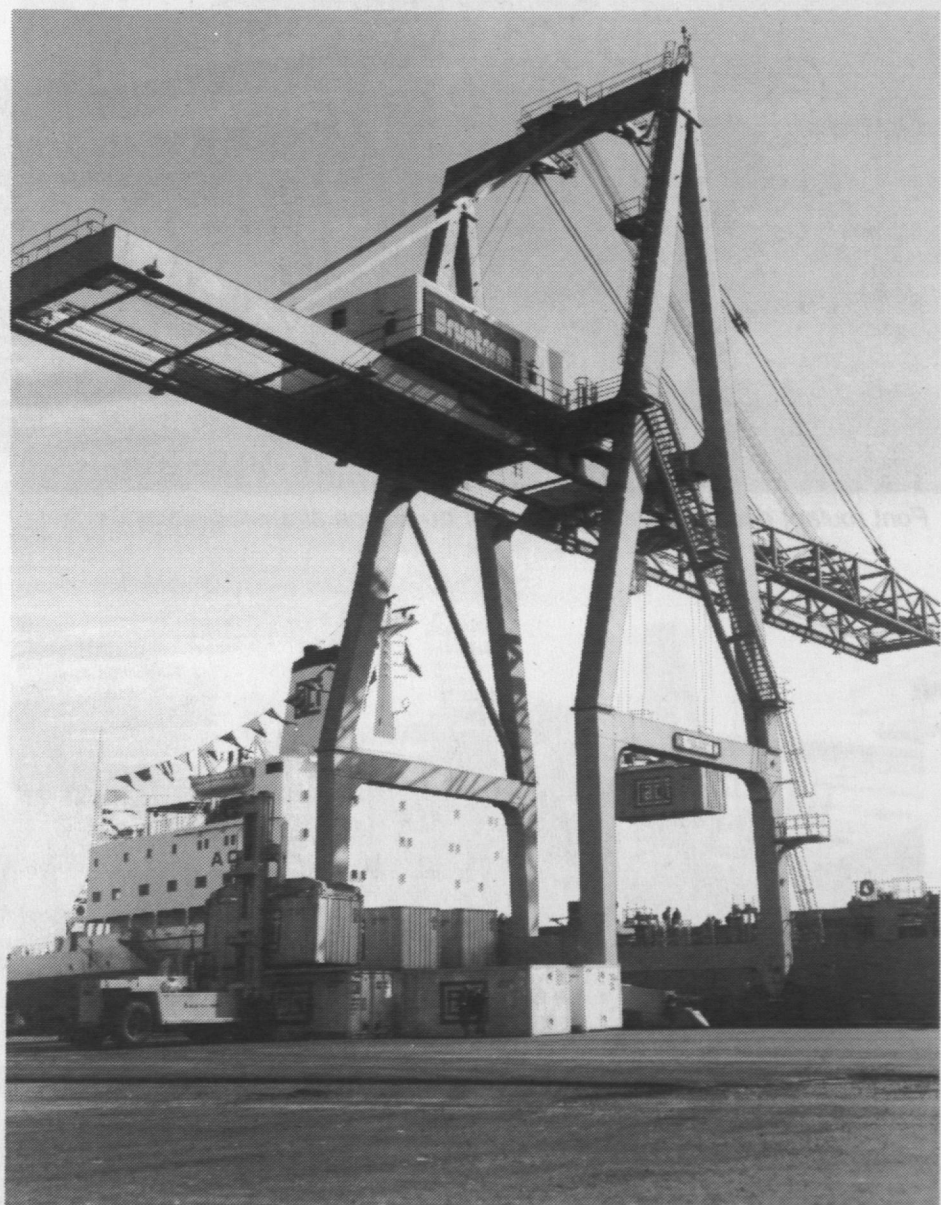
Grue de quai de type courant.
