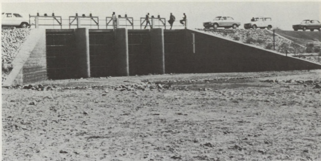
Barrage à sec au Niger.
