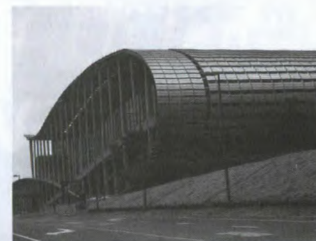
Centre des expositions de Guangzhou.
