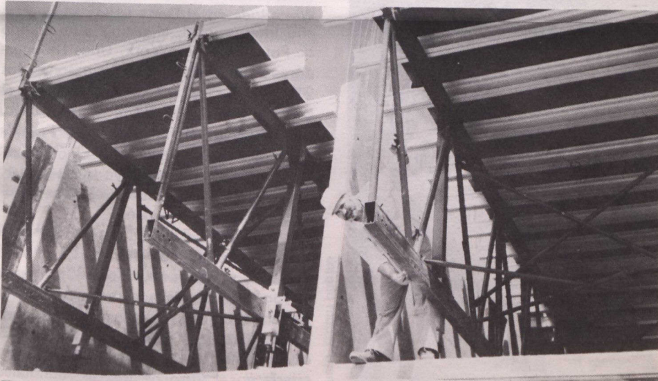
Trabajador colocando parte del sistema de encofrado exportado por la Anthes Equipment Ltd.
