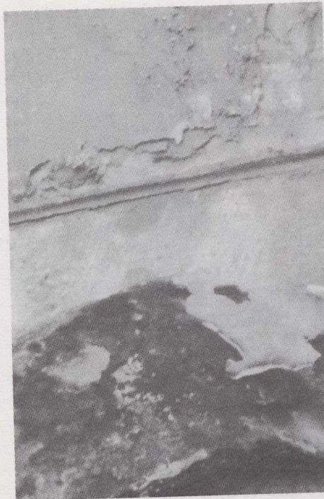
Le lessivage répété par les pluies acides finit par ronger la surface des automobiles, des édifices, des monuments funéraires et d'œuvres d'art sculptées dans la pierre. Des structures architecturales telles que les édifices du Parlement, à Ottawa, ont déjà subi des atteintes.
