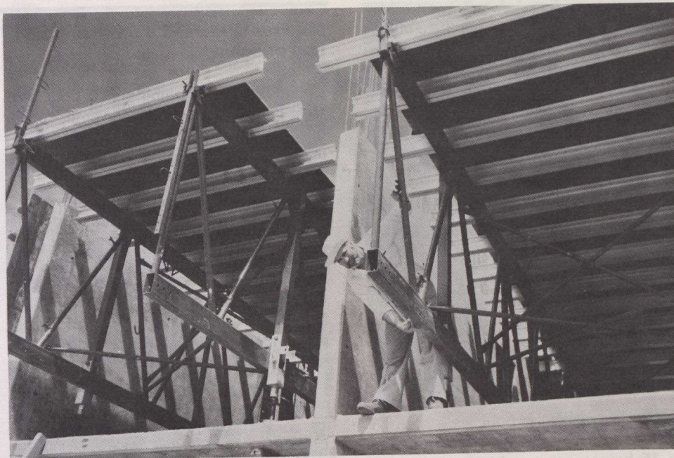
Un ouvrier met en place des éléments d'étagages en treillis d'Anthes Equipment Ltd.
