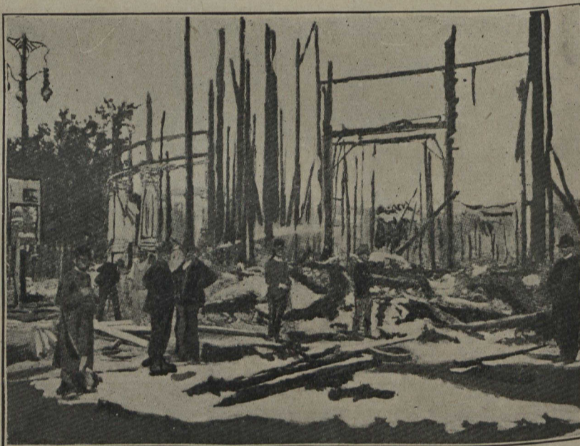
EN ITALIE.—L'incendie partiel de l'Exposition de Milan. La façade du palais des Arts décoratifs, après le sinistre.
