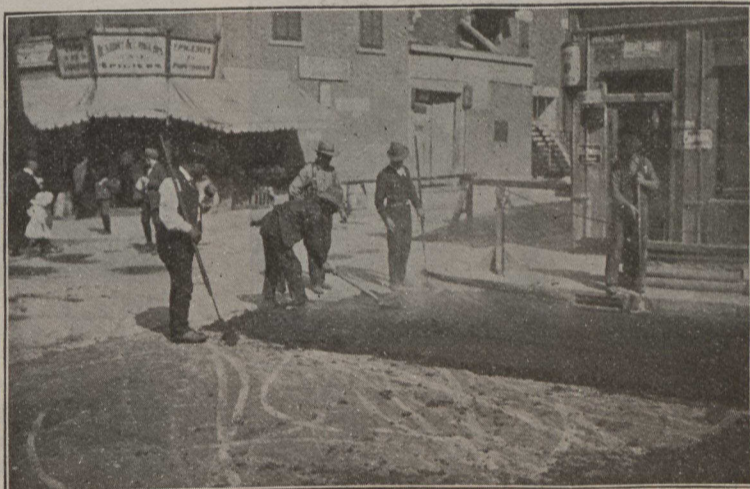
Au moyen de fers chauds on tasse la couche d'asphalte
