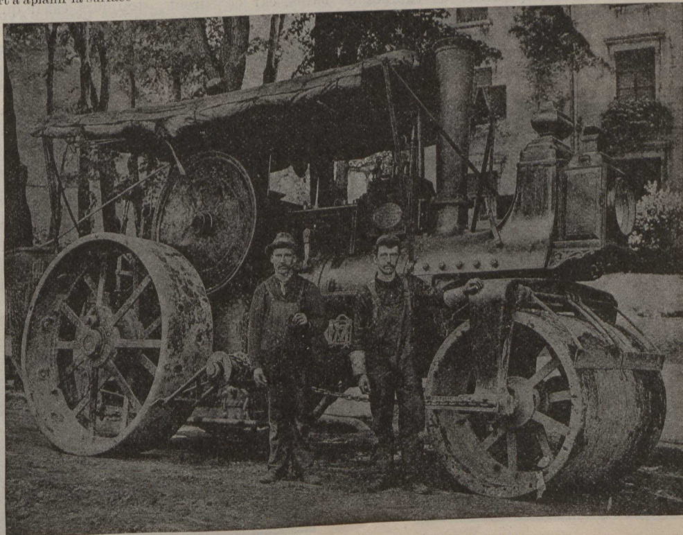
Le rouleau à vapeur perfectionne tous les travaux
