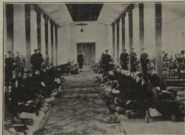
Une salle de l'hôpital japonais, à Dalny
