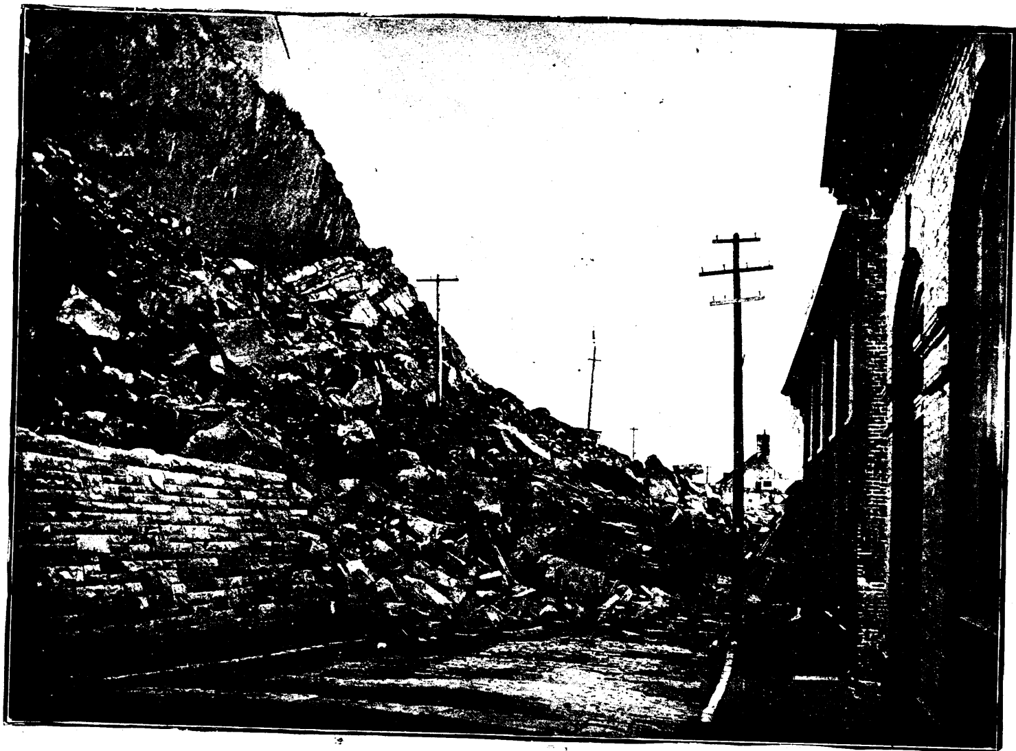
VUES DE L'ÉBOULIS ET DE LA FISSURE (LA RUE CHAMPLAIN PRISE DE L'OUEST)
