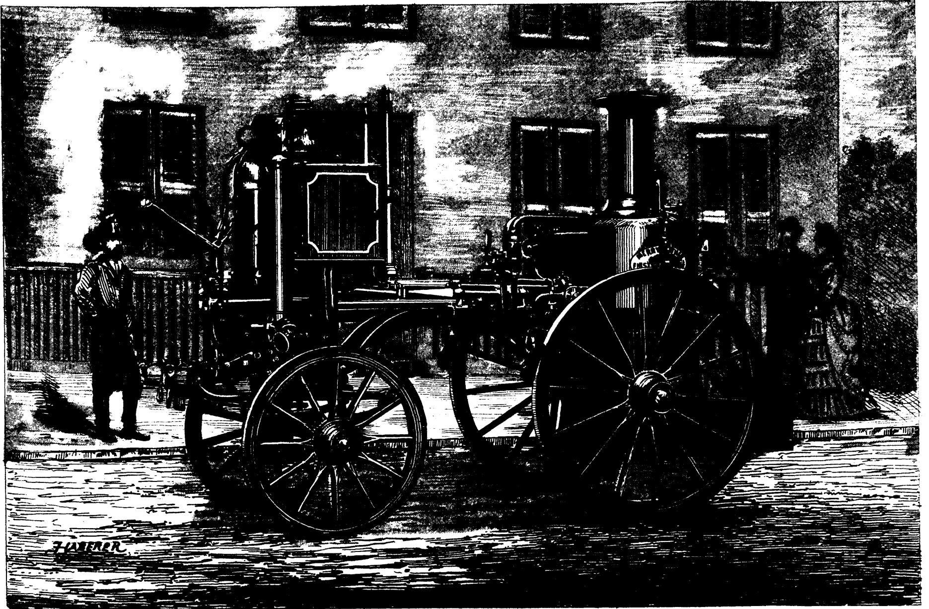
POMPE A VAPEUR POUR LES INCENDIES.
