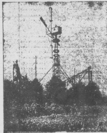
Fig. 2.—Aéromoteur où les pales sont remplacées par des rotors.
