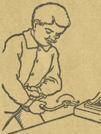
Manière de percer un trou horizontal, la pression sur la pomme est provoquée par le corps de l'ouvrier.
