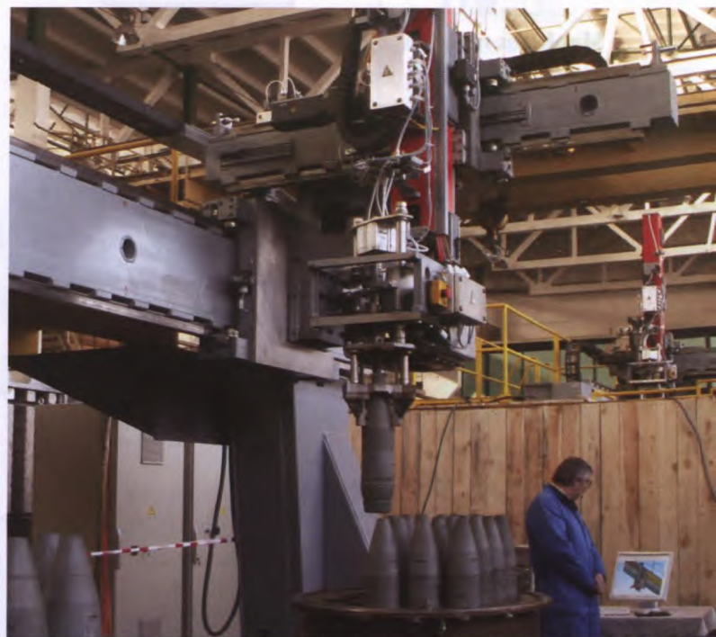
Manipulateurs pour le deuxième bâtiment de destruction, à l'usine de destruction d'armes chimiques de Shchuch'ye
