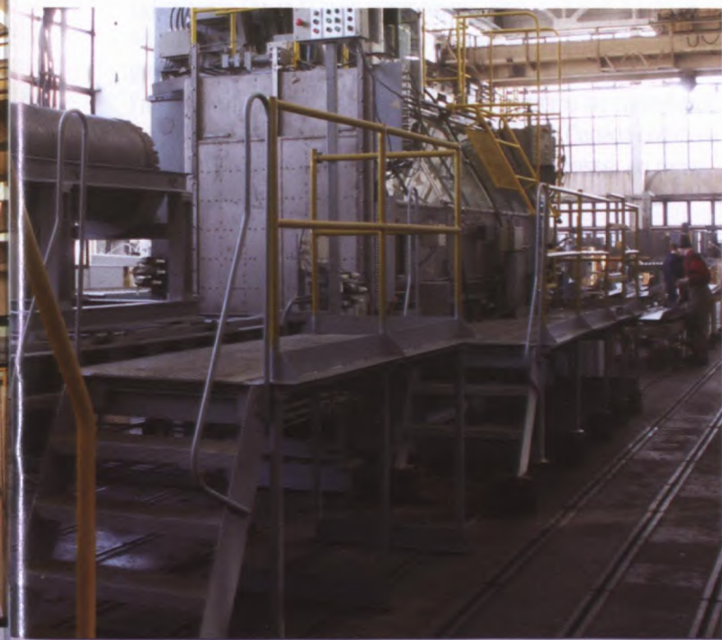
Chaîne de destruction d'armes chimiques pour le deuxième bâtiment, à l'usine de destruction de Shchuch'ye
