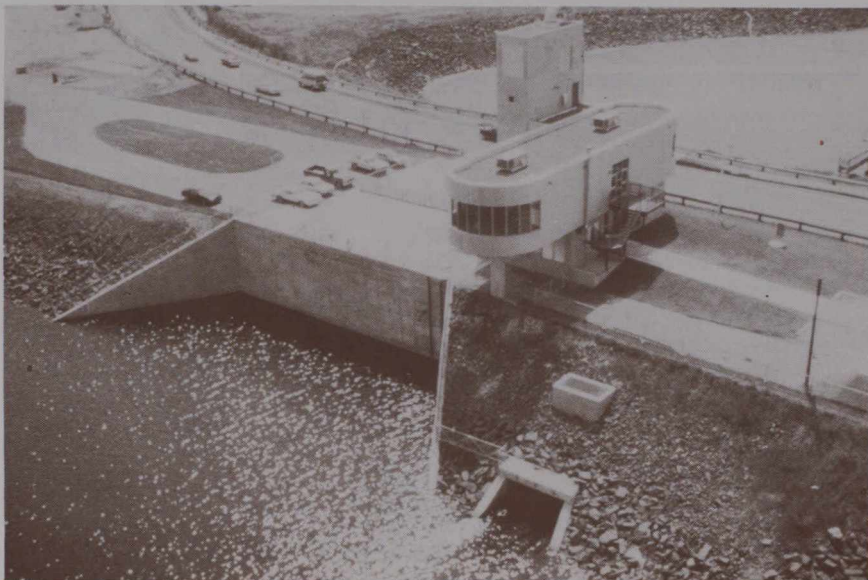
● La centrale d'Annapolis-Royal vue du côté du réservoir. On aperçoit sur la droite une échelle à poisson.
