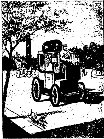
LONDON ELECTRICAL CAB.
