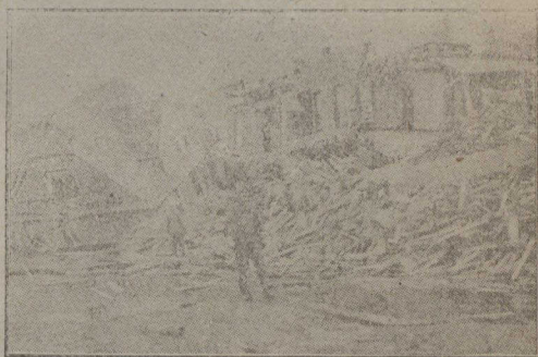
Ceci était une rue coquette avant l'inondation.
