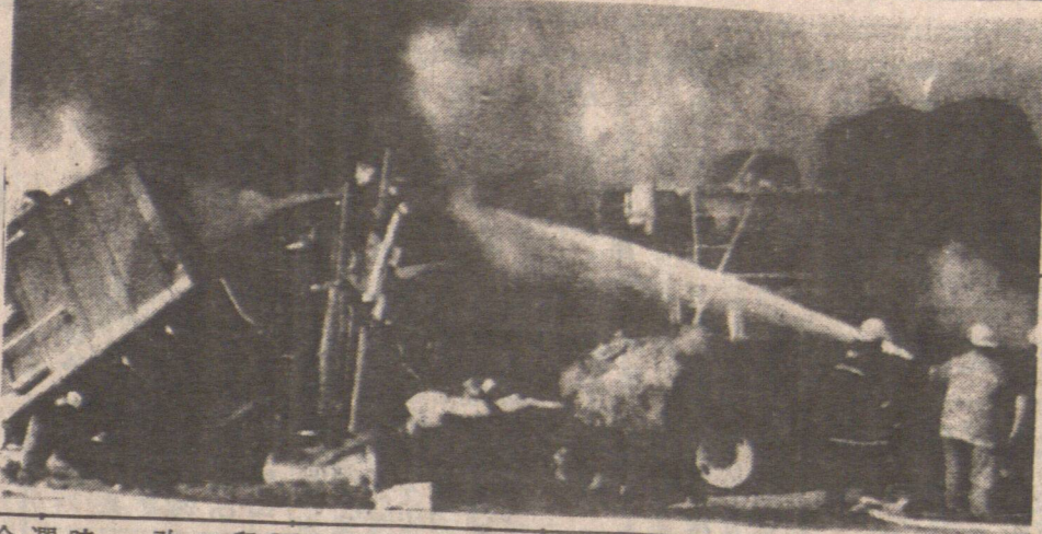
智利軍火廠爆炸，造成卅人喪生，約有五百人受傷。爆炸發生在該廠內，該廠是智利最大的軍火製造廠，生產各種槍械、彈藥、手榴彈、地雷等。爆炸發生後，該廠被大火吞噬，濃煙沖天。智利政府已下令關閉該廠，並派軍隊戒嚴。目前，死傷人數仍在上升中。
