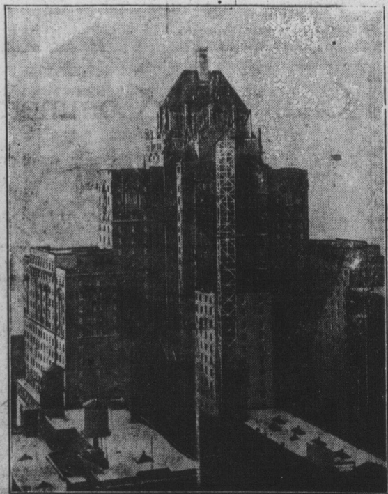
La gravure ci-dessus fait voir l'aspect de ce gigantesque hôtel "Royal York", que le Pacifique Canadien a fait construire l'an dernier à Toronto et auquel il doit déjà, faute d'espace suffisant, ajouter une nouvelle aile de 150 chambres. Les travaux sont passablement avancés, comme on peut le voir ici. Cette aile s'ajoute en effet au centre de la façade arrière et la structure métallique est déjà terminée. Avec cette addition, le nombre de chambres du "Royal York" est porté à 1164. L'aile pourra être occupée vers le mois de juin.
