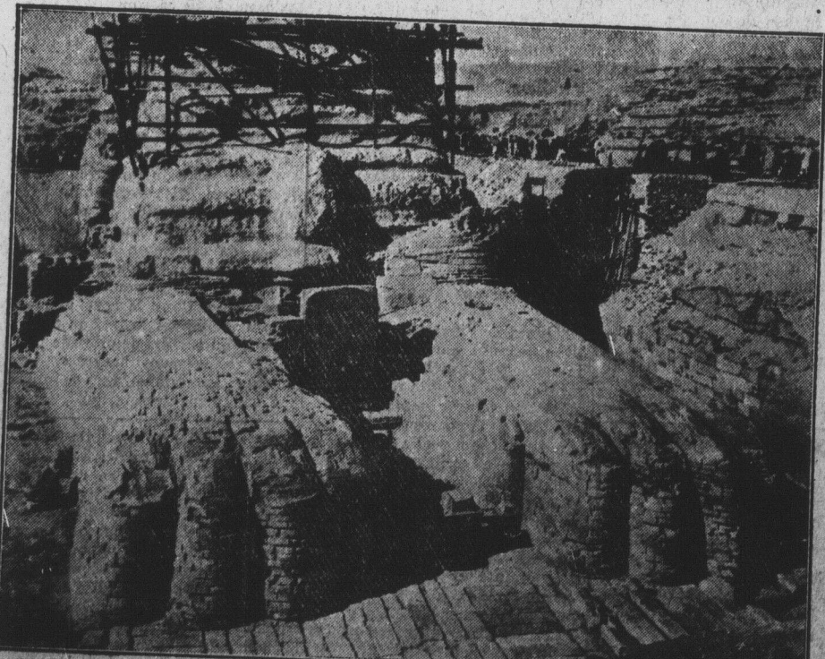
Après avoir été pendant plusieurs siècles sous les sables du désert, les restes du Sphinx viennent d'être remis à jour à la suite de longs et coûteux travaux d'excavation, sous la direction des ingénieurs de la Harvard Foundation. Lors de leur passage en Egypte, les touristes canadiens et américains qui font actuellement le tour du monde sur l'"Empress of Scotland" du Pacifique Canadien, ont pu visiter ces fouilles intéressantes.
