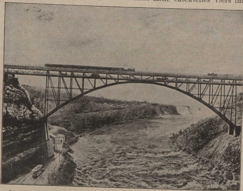
Le pont suspendu par le Grand Tronc au-dessus des gorges en face des Chutes Niagara
