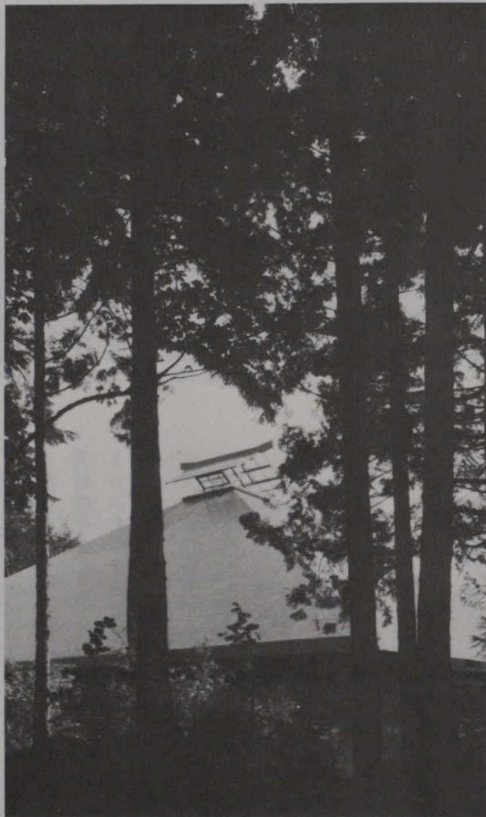
▲建設中のアジア・センター
