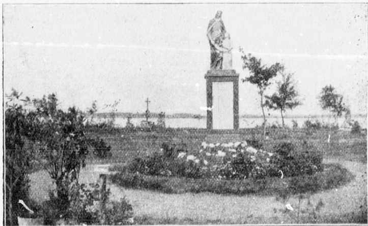
Fig. 44. Au centre de l'ancien Fort Sainte-Anne.
