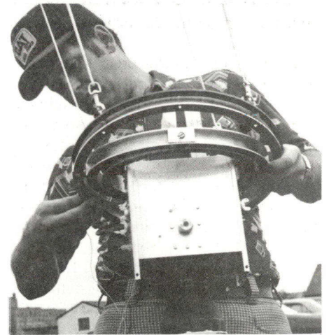
Un technicien jette un dernier coup d'oeil à la caméra télécommandée, prête à monter dans les airs avec le ballon (photo ci-dessus). La caméra, suspendue à 250 pi du sol, photographie le terrain; lorsqu'elle commence à fonctionner, on déplace le câble auquel le ballon est attaché (photo ci-contre).
