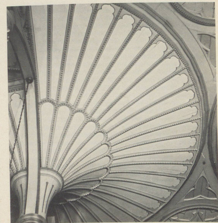
The fan-vaulted ceiling of the Chapel interior represents early Quebec religious architecture. Major elements of the fan vaults, windows and reredos were photographed to scale by the Photogrammetric Section of NRC. After the photographs were taken, the interior of the Chapel was disassembled and stored. Using photogrammetric reproductions, the Chapel interior will be authentically reassembled, possibly in a future National Gallery. • La voûte d'arête ogivale de la chapelle représente bien l'architecture religieuse des premiers siècles installés au Québec. La section de photogrammétrie du CNRC a photographié les éléments principaux de cette voûte, des fenêtres et des retables pour qu'elle puisse reconstituer éventuellement cette chapelle dans un musée national.
