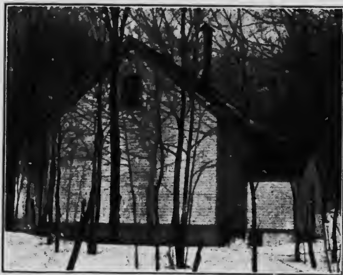
Fig. 158. —Entrepôt frigorifique à l'Institut Agricole d'Oka.
