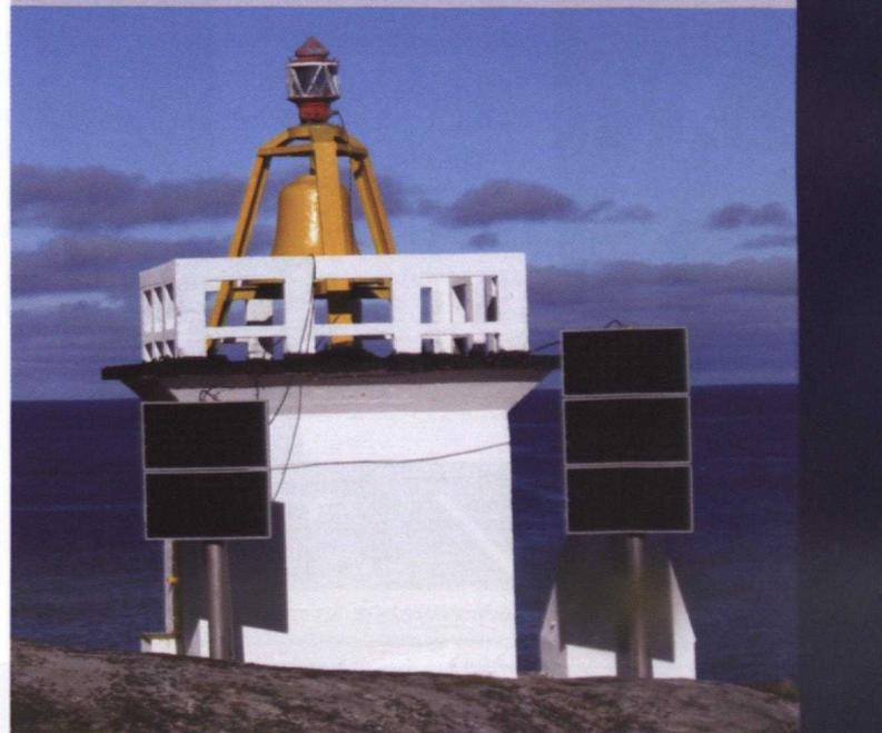
Les panneaux de cellules solaires constituent une source d'énergie durable de remplacement aux matières hautement radioactives qui alimentent les phares.
