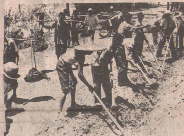
通交復快路道復修速迅眾區災
