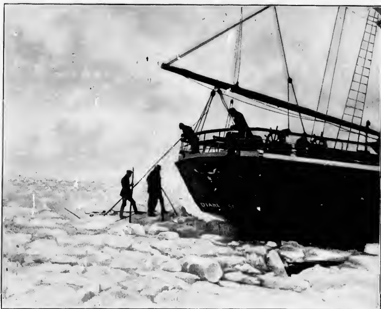
PERCEMENT DE TROUS DANS LA GLACE POUR Y PLACER DE LA POUDRE AFIN DE DÉGAGER LE GOUVERNAIL ET LA POUPE (30 JUIN.) [13
