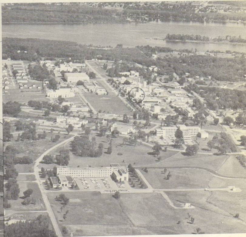
NRC's Montreal Road site in Ottawa is heated by a central plant. • Les bâtiments du CNRC, chemin de Montréal, à Ottawa, sont chauffés par une centrale.
