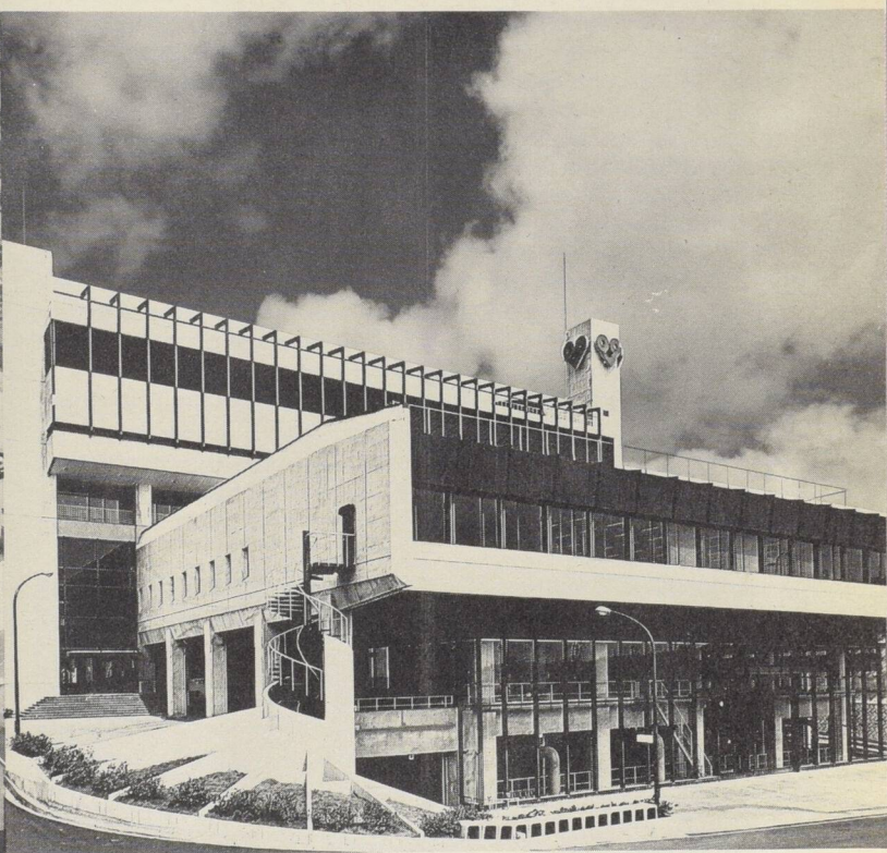
Large-scale district heating plant in Osaka, Japan. • Centrale de chauffage urbain à Osaka, au Japon.
