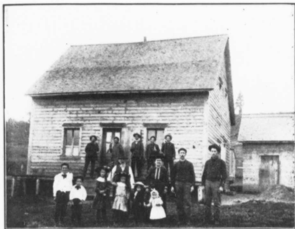
Saint-Zénon.—Habitation de M. Adélarde Brûlé.
