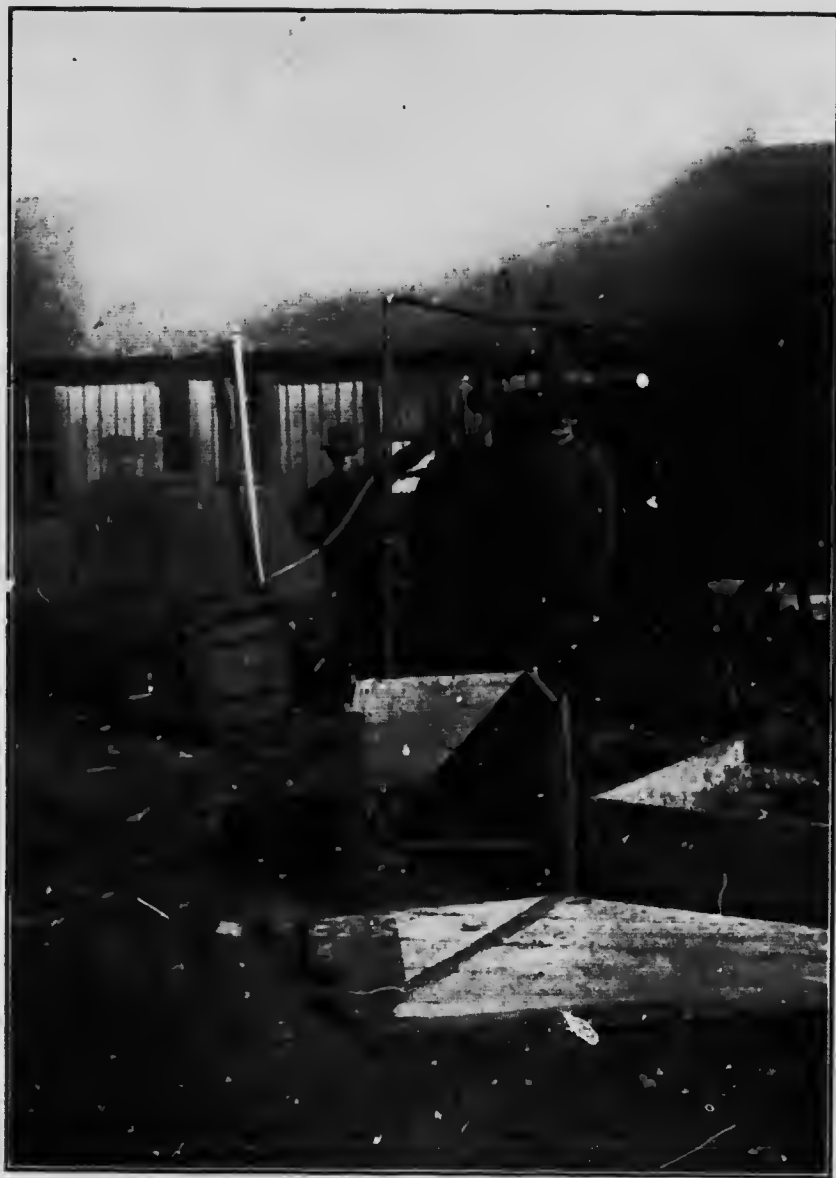
Planche III. - Stérilisation des terrains. (Montrant la disposition intérieure de la caisse employée. — A l'arrière plan le générateur de vapeur.)
