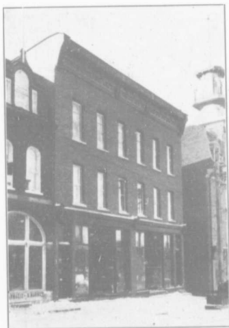
Residence of F. PICHETTE 62 Cote du Passage
