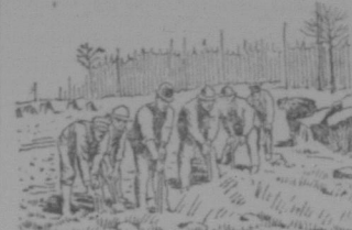
Das Bohren von Sprenglöchern.
