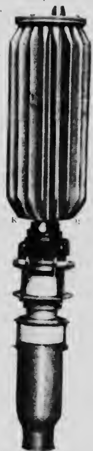
Fig. 1.023. Anode of Rectifier.
