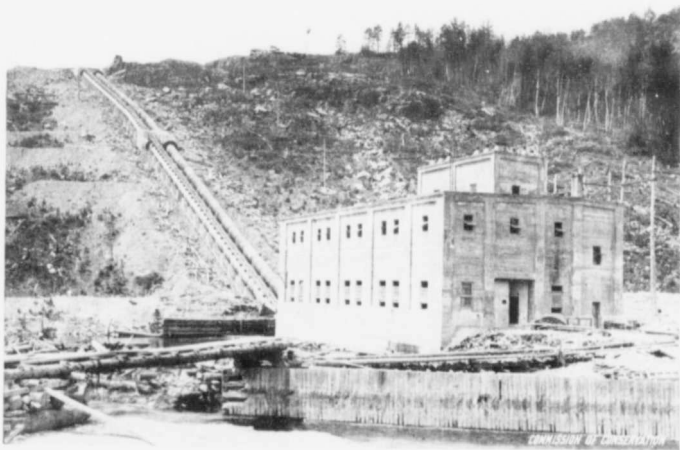
USINE HYDROELECTRIQUE DE LA NORTHERN ONTARIO LIGHT AND POWER CO., SUR LA RIVIERE MATABITCHUAN, DIST. DE TEMISKAMING, ONT., A 25 MILLES AU SUD DE COBALT, ONT.
