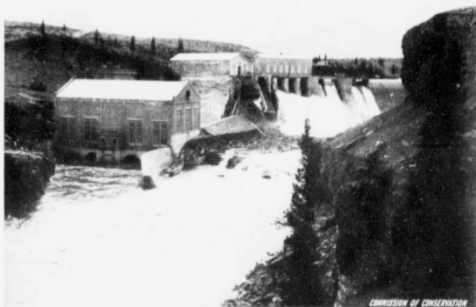
USINE HYDROELECTRIQUE DE LA CALGARY POWER CO. — LA CHUTE HORSESHOE, 50 MILLES À L'OUEST DE CALGARY, ALTA.
