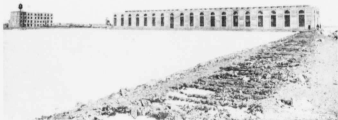
USINE DE LA MONTREAL LIGHT, HEAT AND POWER CONSOLIDATED, AUX RAPIDES DES CÉDRÉS - COURSIER D'AMONT, USINE ET BATIMENT DES TRANSFORMATEURS, AUX RAPIDES DES CÉDRÉS, FLEUVE ST. LAURENT. CO. DE SOULANGES, QUE
