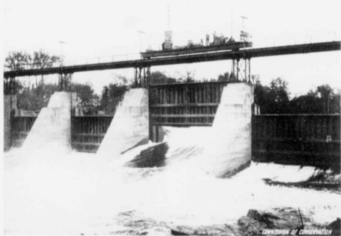
VANNES DE COMMANDE DE LA SHAWINIGAN WATER AND POWER CO., SHAWINIGAN FALLS, RIVIÈRE ST MAURICE COMTE DE ST. MAURICE, QUÉ.
