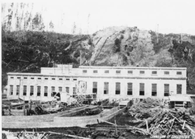
USINE HYDROÉLECTRIQUE DE LA BRITISH COLUMBIA ELECTRIC RAILWAY CO., SUR LA RIVIÈRE JORDAN, À 43 MILES À L'OUEST DE VICTORIA, C. B.
