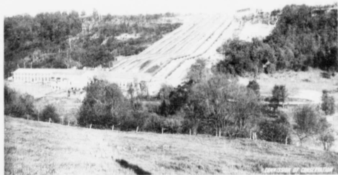
USINE HYDROELECTRIQUE DE LA DOMINION POWER AND TRANSMISSION CO., A POWER GLEN, 33 MILLES A L'EST DE HAMILTON, ONT.
