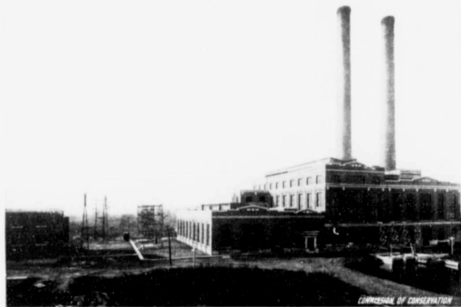
USINE A VAPEUR AUXILIAIRE DE LA DOMINION POWER AND TRANSMISSION CO., A HAMILTON, ONT.
