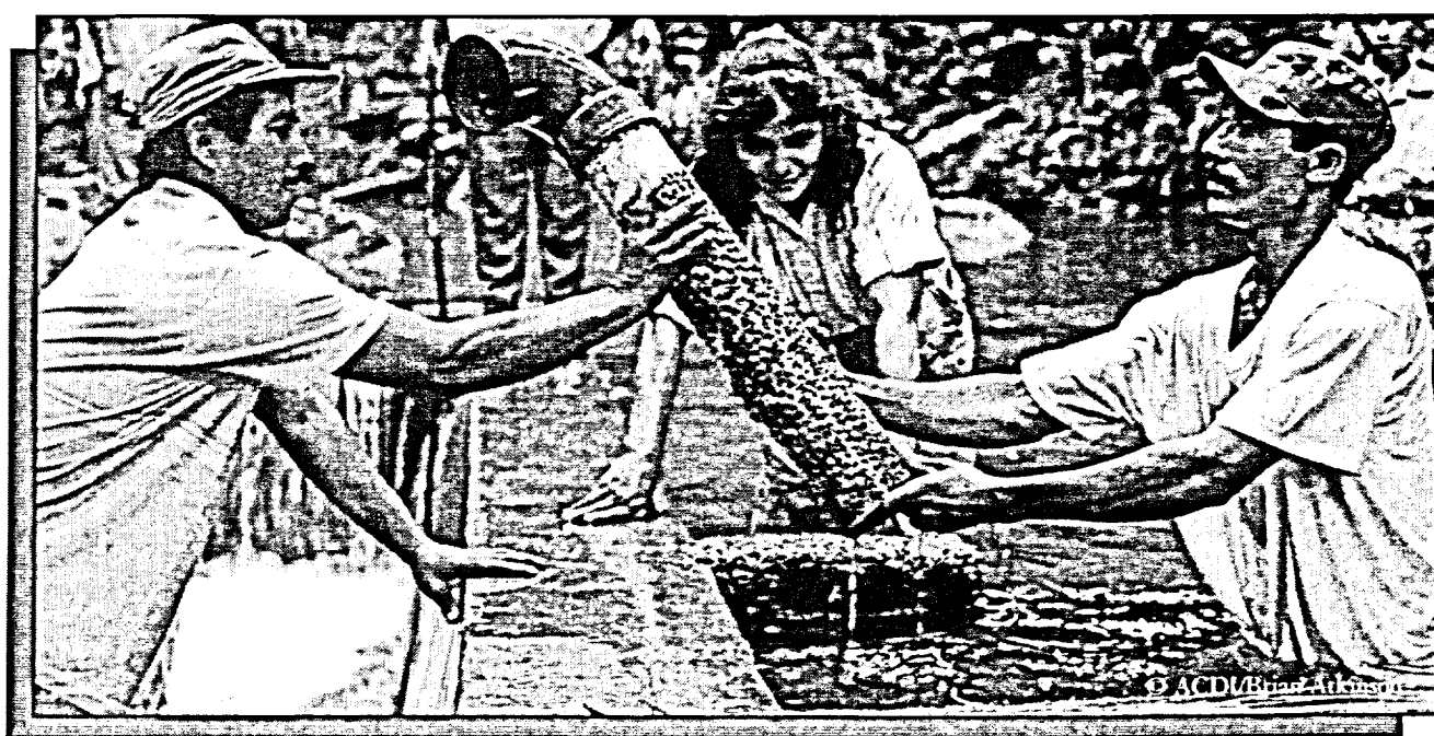
À Palos de Agua, au Honduras, des travailleurs nettoient les filtres d'un barrage dans le cadre d'un projet d'approvisionnement durable en eau et d'assainissement.
