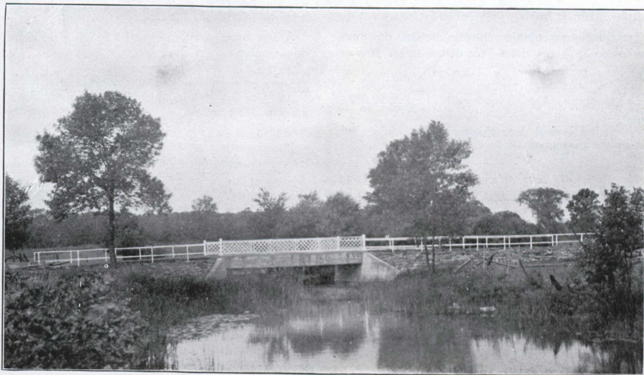
Pont Doré, sur la rivière Chicot, à St-Eustache, comté des Deux-Montagnes. Pont en béton armé d'une travée libre de 35 pieds. Pont construit en 1920.
