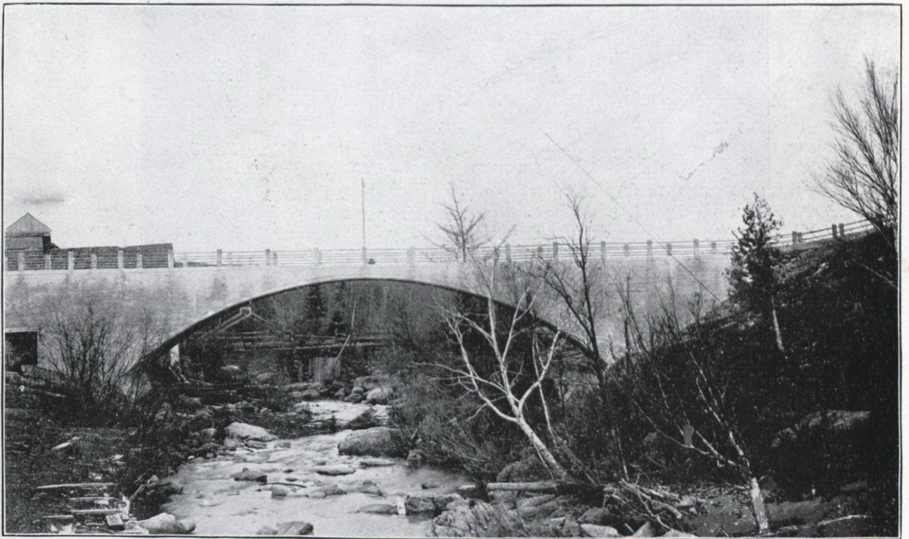
Pont en arche sur la rivière Fourche du Pin, à St-Philémon, comté de Bellechasse. Ce pont a 129 pieds de longueur et l'arche a 80 pieds d'ouverture aux naissances. Ce pont a été construit en 1918.
