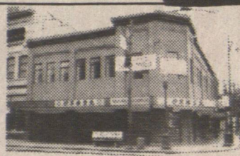
▲ 唐人街地王, 五層商業樓宇 樓上七千呎可做酒樓及寫字 樓, 街角地 50x120 梁寶琴。 ▲ 4層屋出售 2980 NANAIMO, 交通便 生意好, 租平開價 $15,000 3個單位連理, 4個單位 電燈, 2個單位洗滌。 黃光照 645-3232
