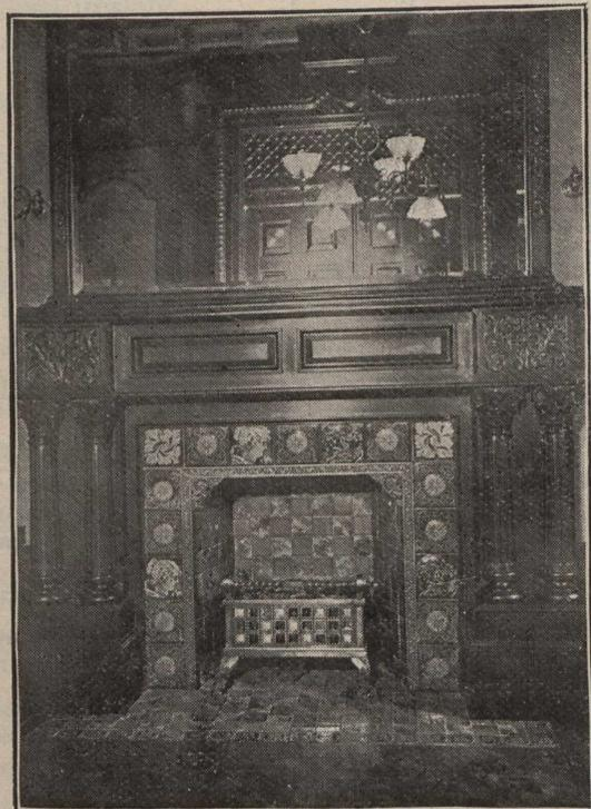
Cheminée moderne, avec bûchettes artificielles pour chauffage au gaz d'éclairage
