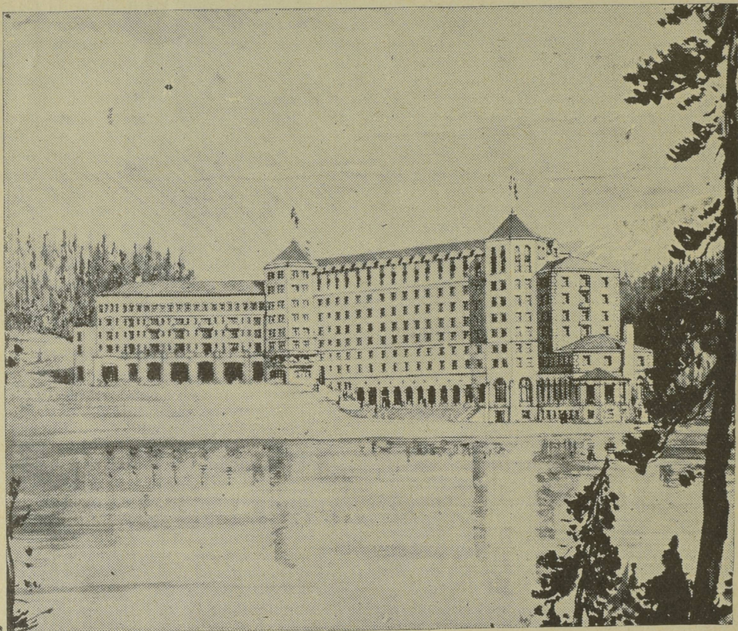
LE NOUVEL HÔTEL QUE LA COMPAGNIE DU PACIFIQUE CANADIEN EST À FAIRE CONSTRUIRE AU LAC LOUISE, DANS LES MONTAGNES ROCHEUSES
