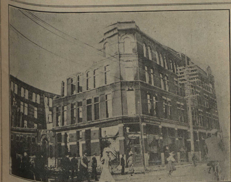
A OTTAWA — Ce qu'il reste de l'hôtel Gilmour, d'Ottawa, que détruisit un récent incendie, où périrent plusieurs personnes. Cet hôtel, situé au coin des rues Bank et Gilmour, sera dit-on prochainement reconstruit.
