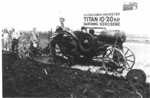
I. H. C. 10-20 Kerosene Tractor pulling a 3-furrow P. & O. Plow
