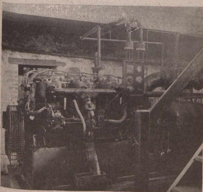
FIG. 1—GASOLINE-ENGINE-DRIVEN FIRE PUMPS
