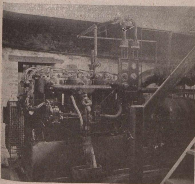
FIG. 1—GASOLINE-ENGINE-DRIVEN FIRE PUMPS
