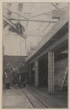
Fig. 1 .- Lifting Tubes to Rattler.
