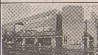
▲ 2250-2290 COMMERCIAL DR. 9 年新商業樓。四個零售舖位。另廚房。二樓三樓寫字樓。另 99 個地下停車位全租出。約 $300,000. TRIPLE NET 年 收入。開價 $380,000。梁寶琴 688-7888
