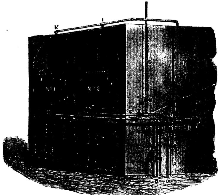
FIG. 2.—MESSINGER BOILER FEEDER AND ATTACHMENTS.
