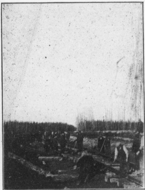
CONSTRUCTION DU TRANSCONTINENTAL AU LAC DAVY, DANS L'ABITIBI.
